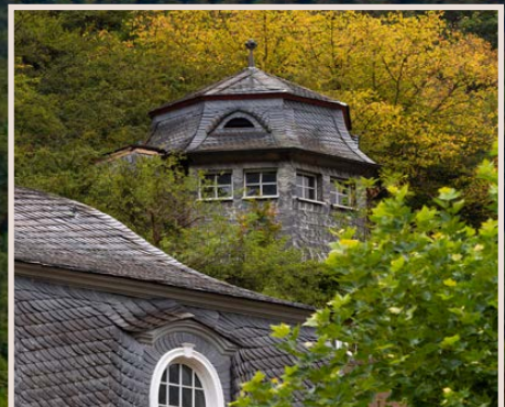
Wasserturm Bad Bertrich
